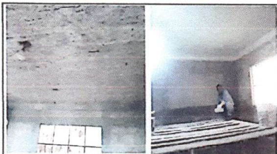
Foto 3: Impermeabilización de losa para dos aulas del primer nivel
