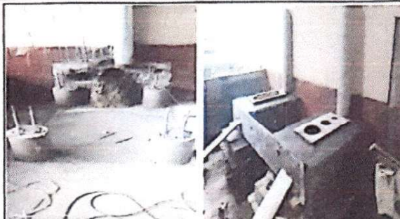
Foto 2: Sustrucción de estufa rural completa para la cocina del establecimiento
