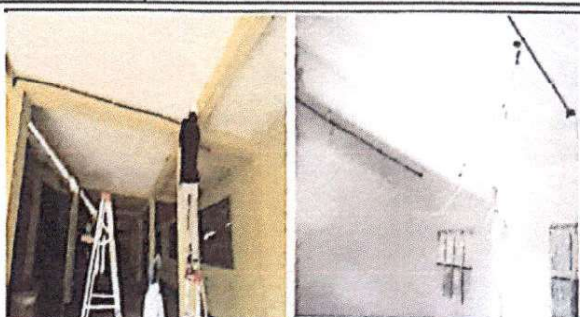
Foto 2: Sustitución de ducto eléctrico + accesorios, de cuatro aulas del primer nivel
